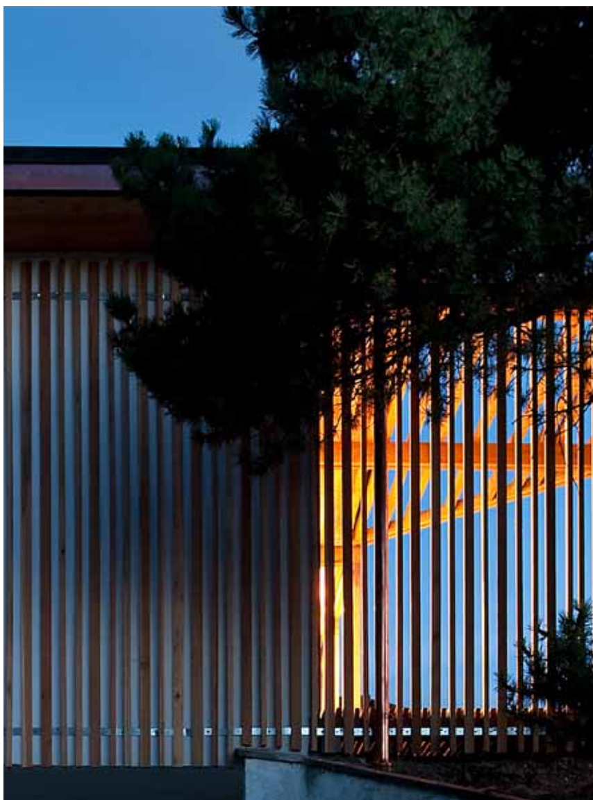
Les anciennes façades ont été conservées et revêtues de decks en mélèze.
