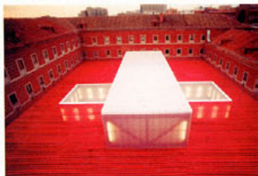
Zwei Balken rechtwinklig übereinander gelegt, fachwerkartig versteift und mit weissem Acrylglas verkleidet (2b Architectes)
